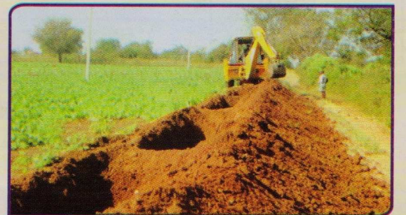
Trench Cum Bund
